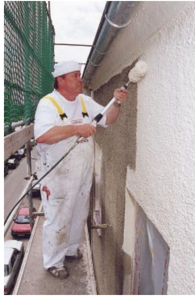
7 In der Fläche sorgt der innen-gespeiste Roller für kontinuierliche Materialzufuhr. Bei einer solch rauen Putzfläche von Hand hätte Horst Hubka sen. die Rolle alle zehn Zentimeter neu eintauchen müssen.
