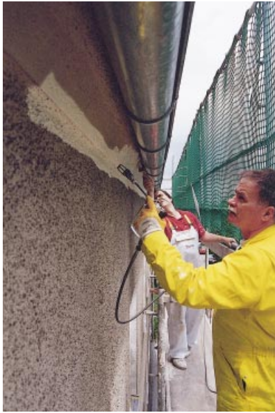
6 Mit etwas Übung funktioniert das Beschneiden sogar ganz ohne Abdecken. Jürgen Stecher legt mit der Spritzpistole vor, Horst Hubka jun. arbeitet wegen der Rauigkeit des Putzes mit dem Pinsel nach.
