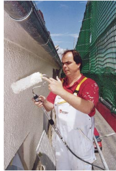
8 Die modernen Roller halten dicht. Anders als früher, tropft an den Seiten nichts mehr heraus.
