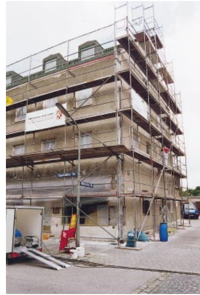
3 700 Quadratmeter Fassadenanstrich. Für den Versuch wurde ein ganz normales Gebäude ausgesucht.
