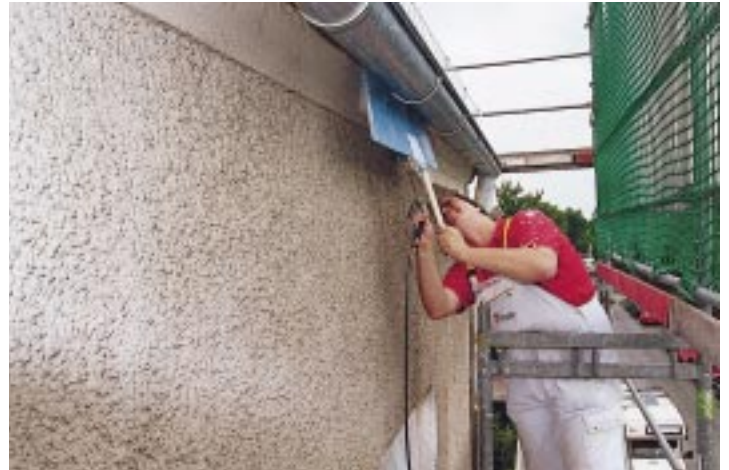
5 Auch im Anschlussbereich zur Dachrinne genügt eine Abdeckplatte.
