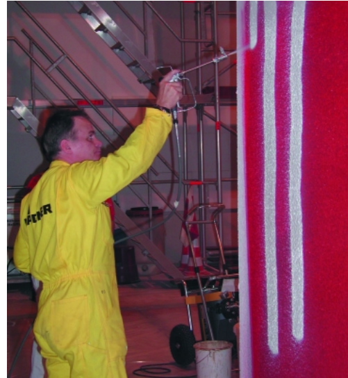
1 Das Spritzen der Fassadenfarben war die Aufgabe von Jürgen Stecher.
